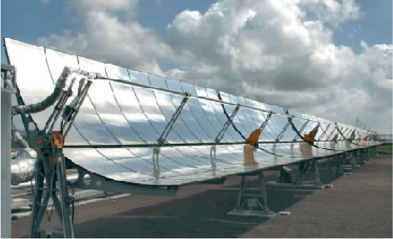
Şekil 7.8. Parabolik Oluk Güneş Kolektörleri
