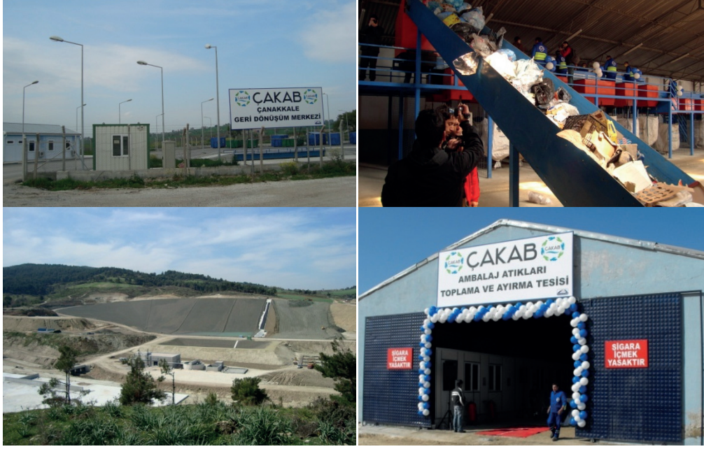
Şekil 8.22. ÇAKAB Katı Atık Depolama Alanı ve Ambalaj Atıkları Ayırma Tesisi (Çanakkale Belediyesi, 2013)
