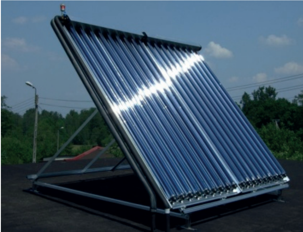
Şekil 7.5. Vakum Tüplü Güneş Kolektörü
