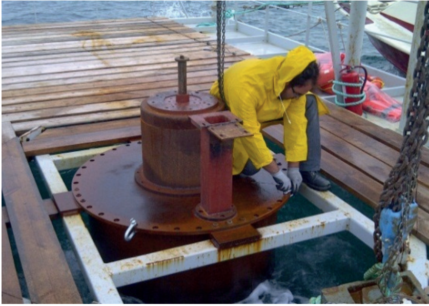
Şekil 10.20. Platformda Pervane Haznesinin Yerleştirilmesi (Özgün)
