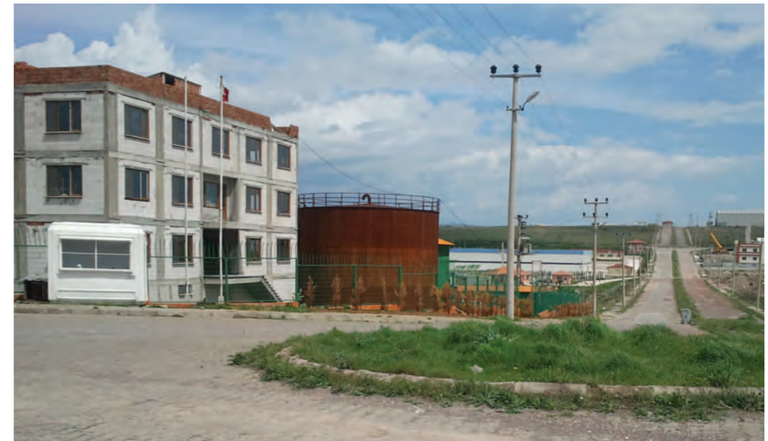
Şekil 11: Bandırma OSB Genel Görünüm
